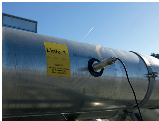
Figura 21. Detector de chispa.
