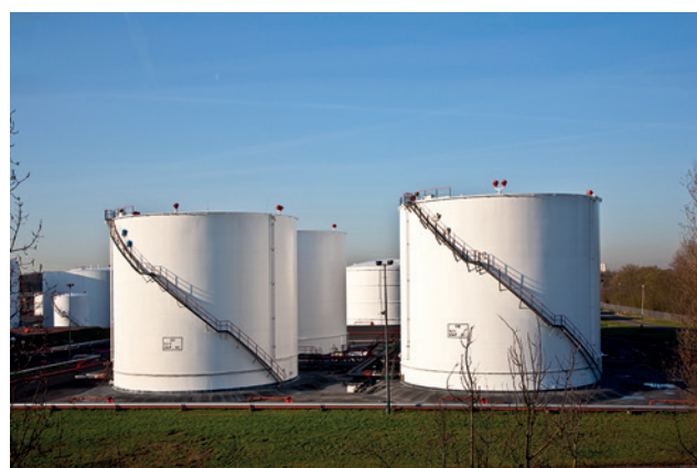
Figura 2. Almacenamiento de hidrocarburos a temperatura y presión atmosférica. Por tanto, si la sustancia emite vapores y en el interior hay aire, hay que aplicar el Real Decreto 681/2003.
