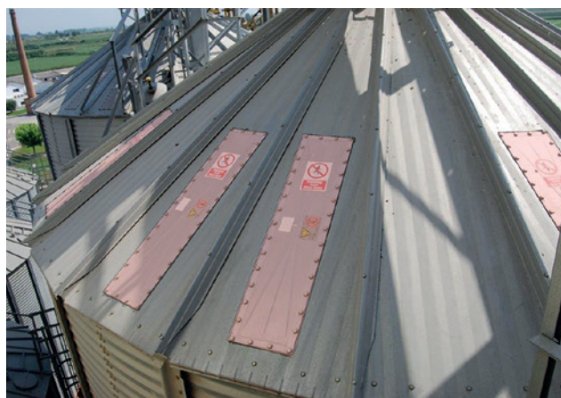
Figura 26. Paneles de venteo instalados en un silo para que en caso de explosión no supongan un peligro para los trabajadores ni afecte a otros equipos.
